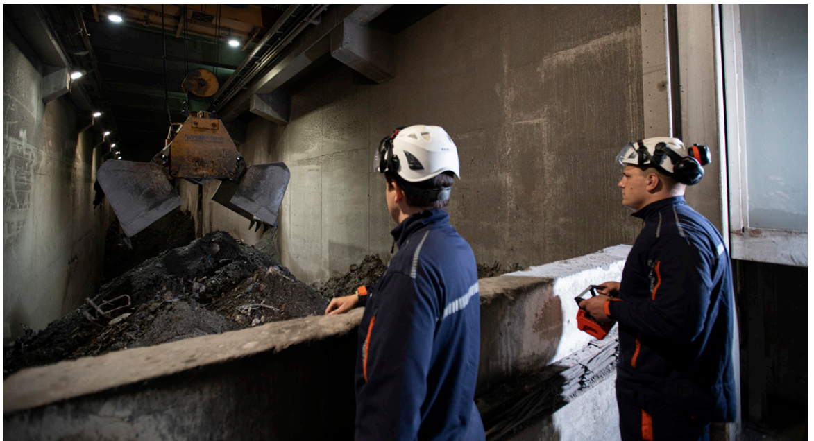
Schlackenbunker, Quelle: EEW
