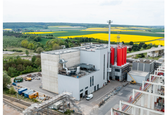
Mono-Klärschlammverbrennungsanlage, Quelle: EEW
