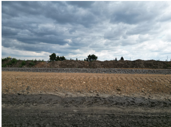
Tragschichten mit EBV-Material, Quelle: Breer
