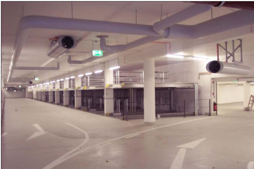
**Bild 24: Impulsventilatoren unter der Decke einer Tiefgarage**
